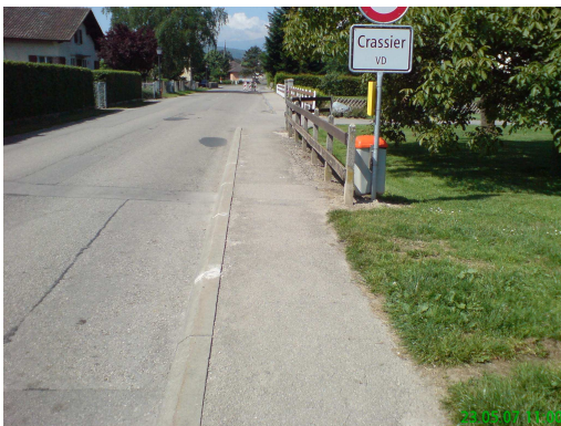
Vue en direction de crassier avec élargissement de la chaussée de 5,70 m à 8,00m
