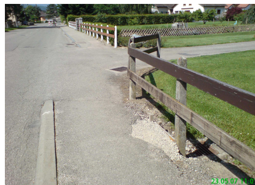
Détail de l'élargissement de la rue
